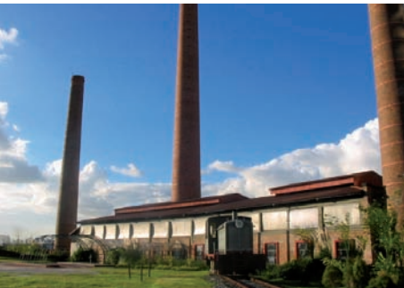
Casa das Caldeiras
